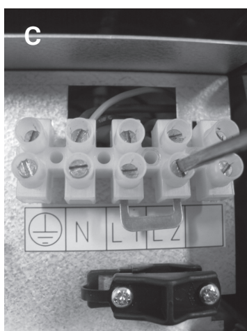
Рисунок 10 С и D. 1-фазное соединение каменки
